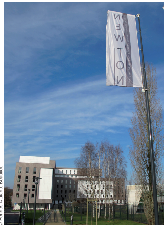
Bâtiment Le Newton. Rennes Atalante.
